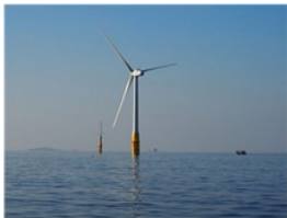
崎山沖2MW浮体式洋上風力発電所(2MW、2013年運開)
